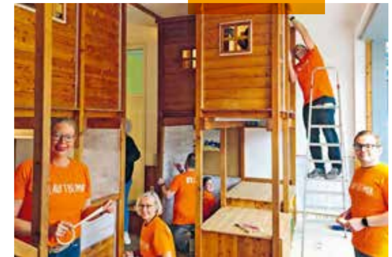
Die Holzeinbauten im SOS-Mütterzentrum in Salzgitter Bad erstrahlen dank elf fleißigen Helfern in neuem Glanz.
